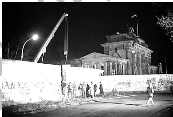
Демонтаж секции Берлинской стены возле Бранденбургских ворот, 21 декабря 1989 года ( Источник: commons.wikimedia.org )
